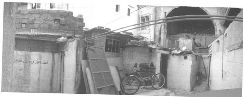
"Minacce" alla patrimonializzazione: il cortile di una casa araba trasformato nel condominio di numerose famiglie palestinesi.
