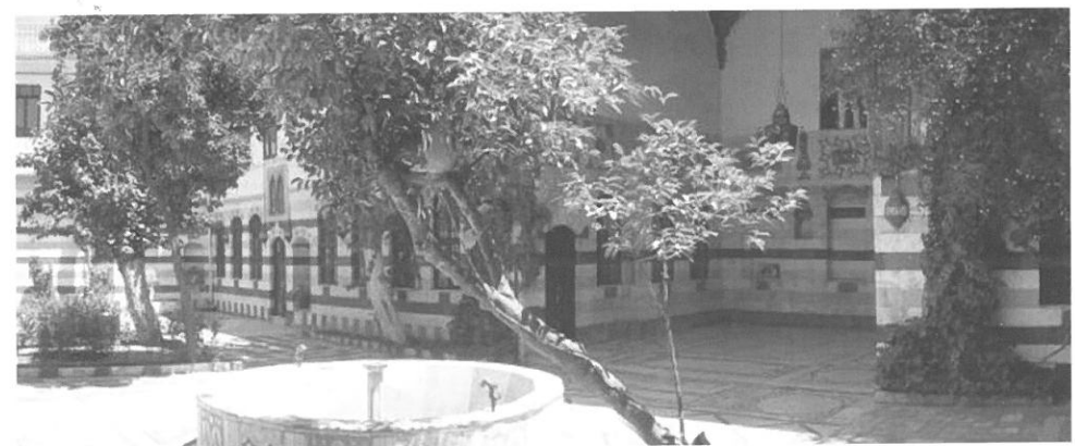
Conservazione delle antichità: cortile di Beit Nizam, "casa araba" di proprietà pubblica restaurata dalla Direzione della Città Antica.
